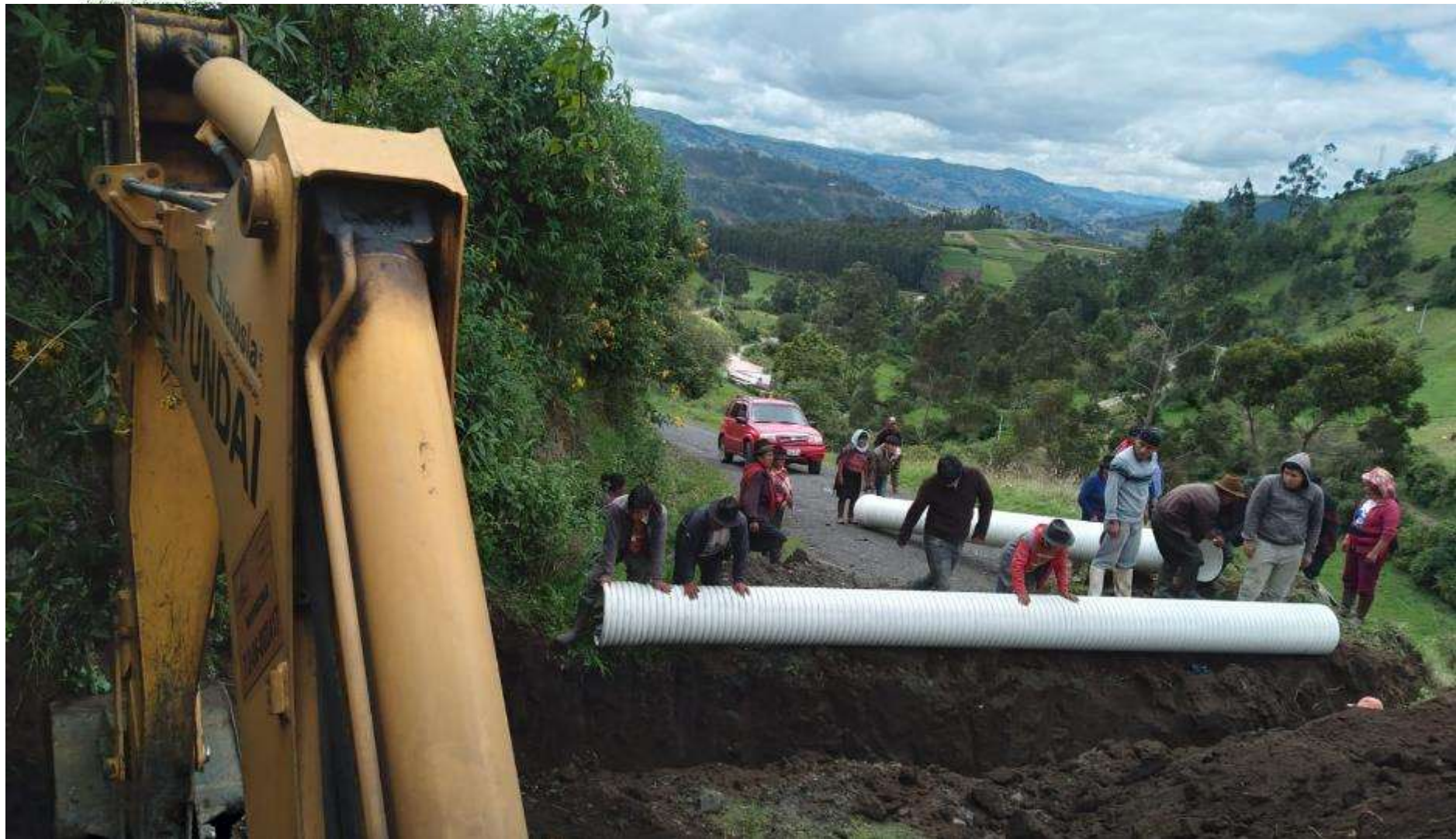
INSTALACION DE TUBERÍAS DE DESFOGUE DE AGUA EN LA VÍA A CHUSGA
