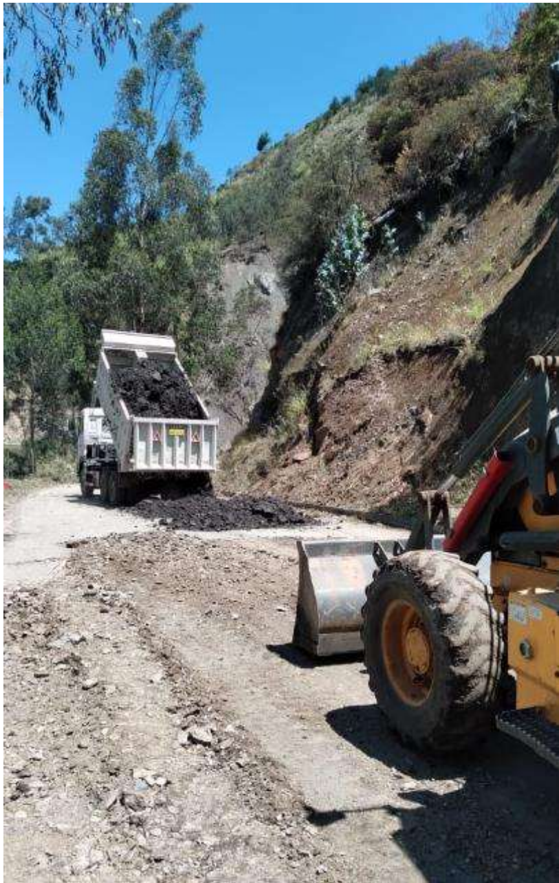
LASTRADO EN PUCARÁ Y TENDIDO DE SUBBASE EN ANGUIÑAY
