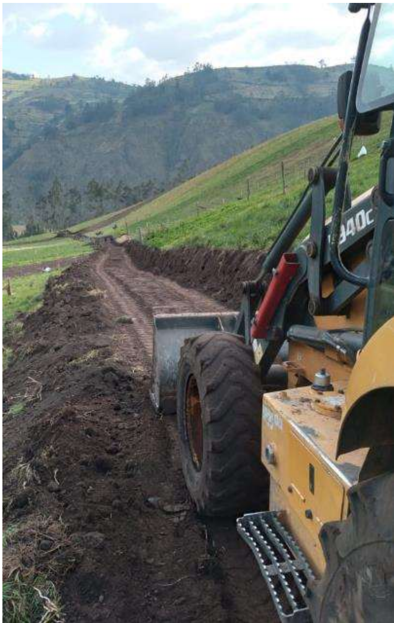
APERTURA DE VIA EN QUISHCAHUAN Y EXCAVACION PARA AGUUA LUVOA EN PELTETEC
