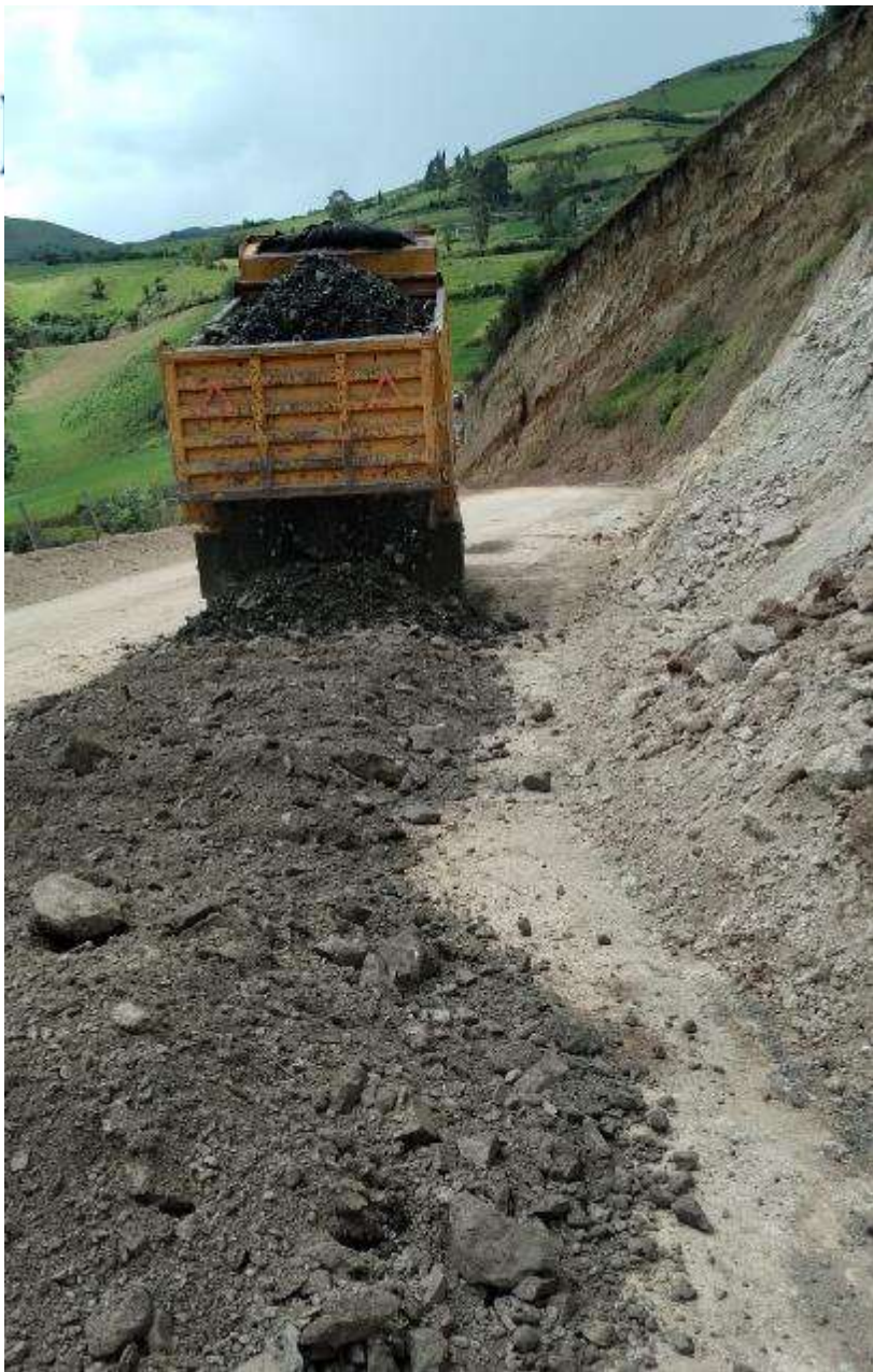
LASTRADO EN PUNINHUAYCO Y LIMPIEZA DE VIA EN PUNGALAPAMBA
