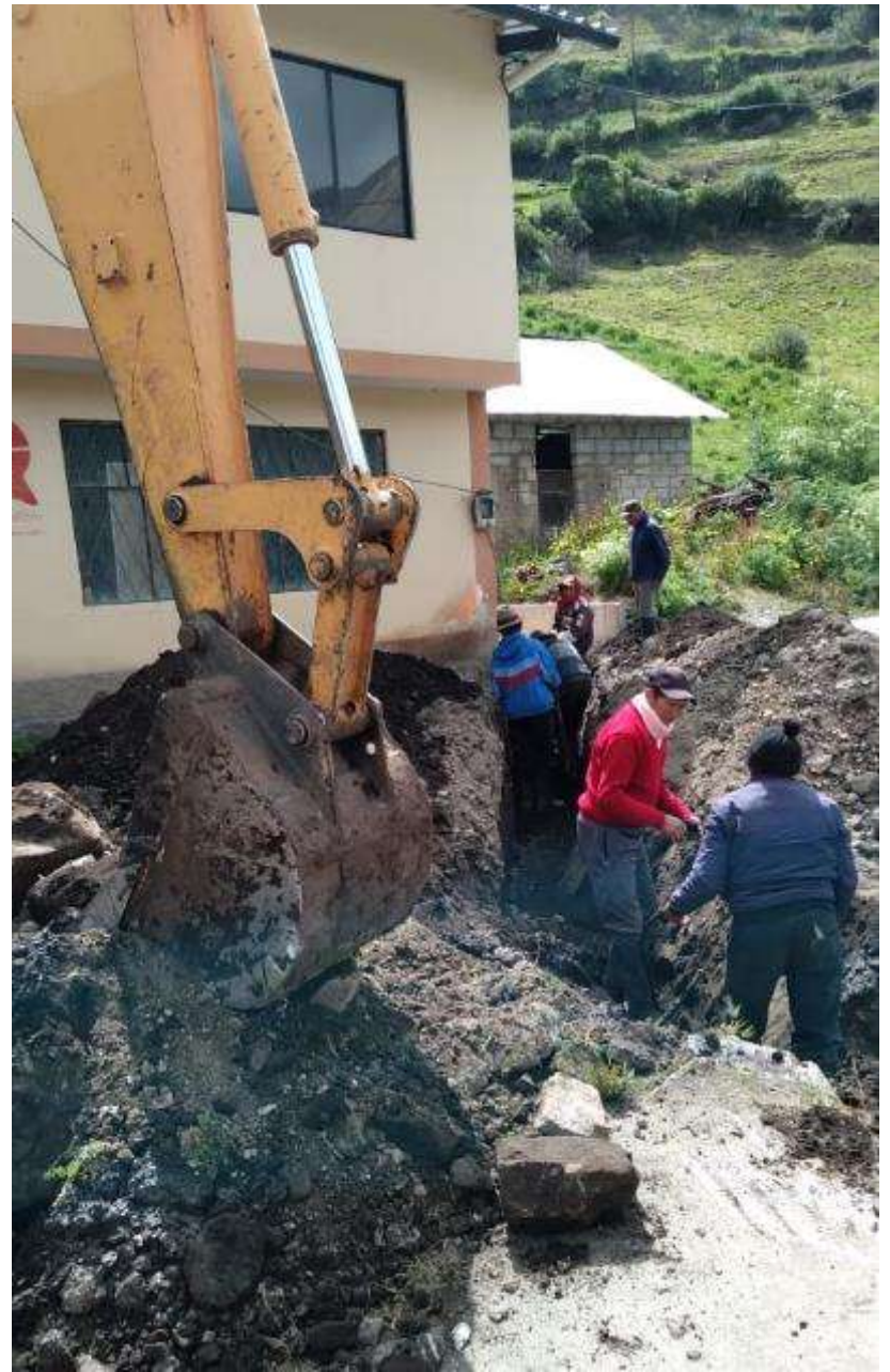
APERTURA DE VIA EN QUISHCAHUAN Y EXCAVACION PARA AGUUA LUVOA EN PELTETEC
