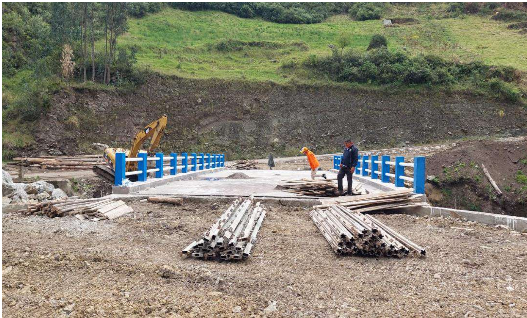
FISCALIZACIÓN AL NUEVO PUENTE HACIA SECTOR PURUHAY
