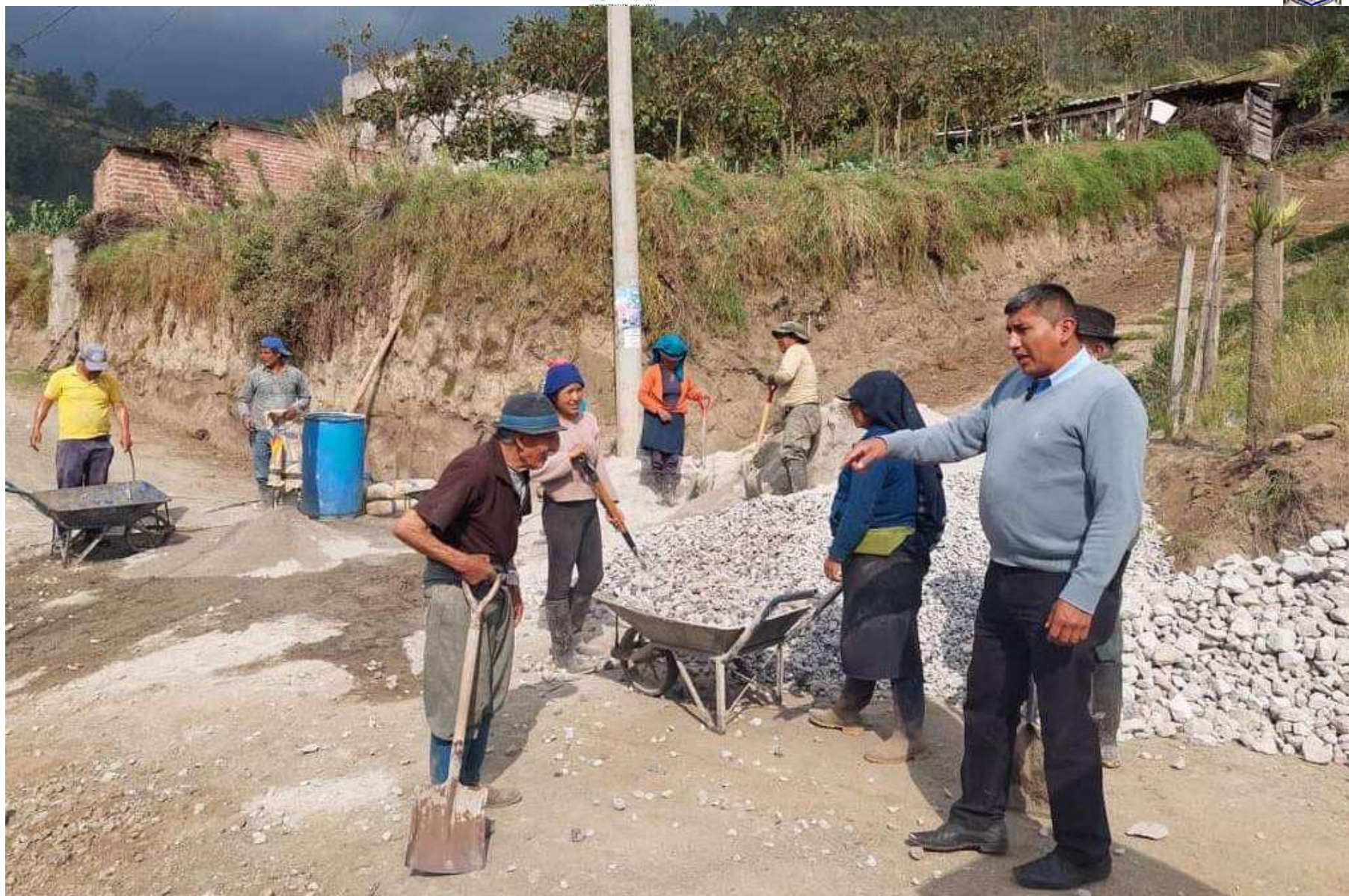
ENTREGA DE CEMENTO Y MATERIAL PÉTRICO PARA CONSTRUCCIÓN DE BORDILLOS EN LA CABECERA PARROQUIAL
