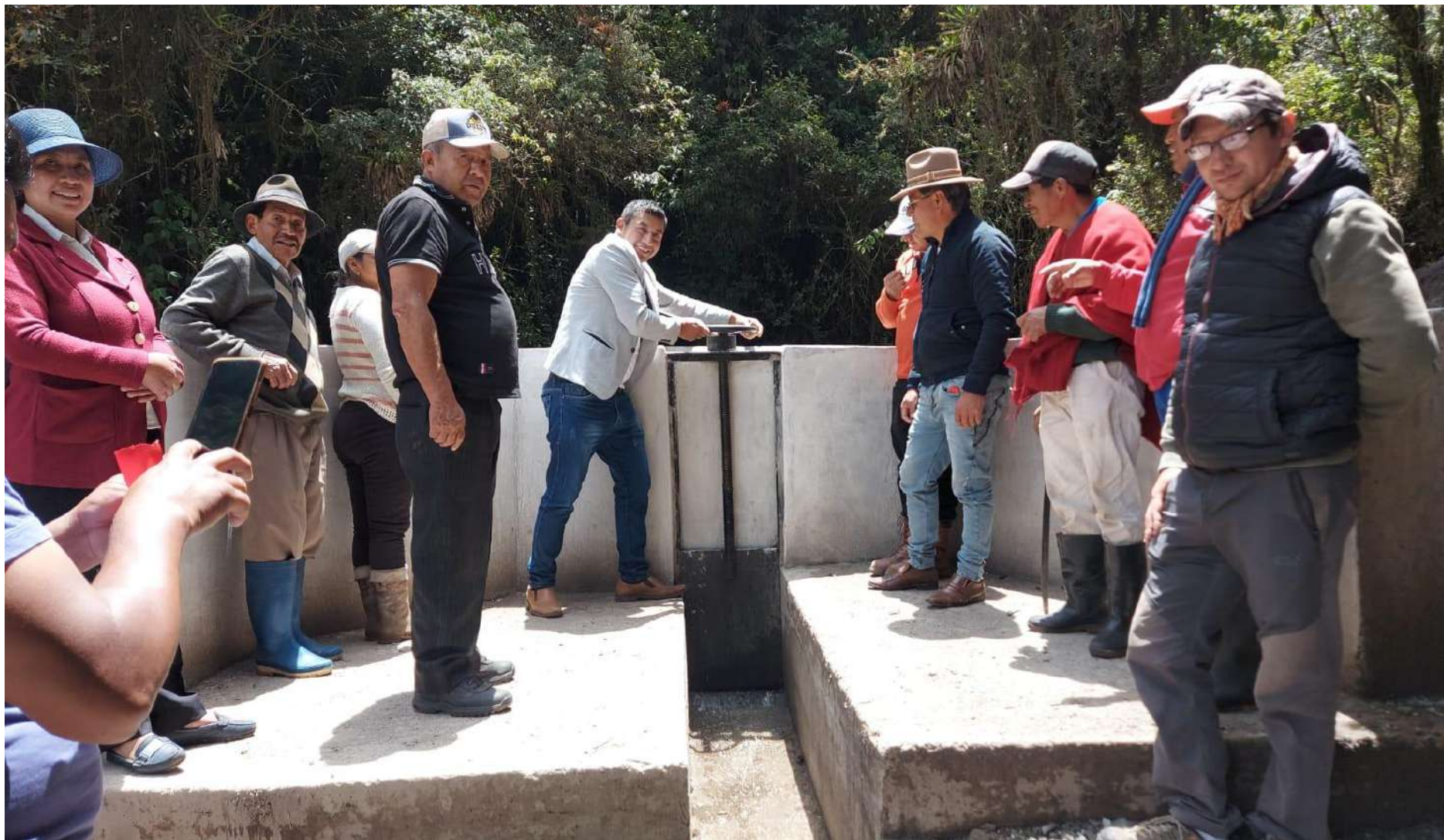
ENTREGA DE MATERIALES PARA CONSTRUCCION DE UNA CAPTACIÓN EN DALDAL
