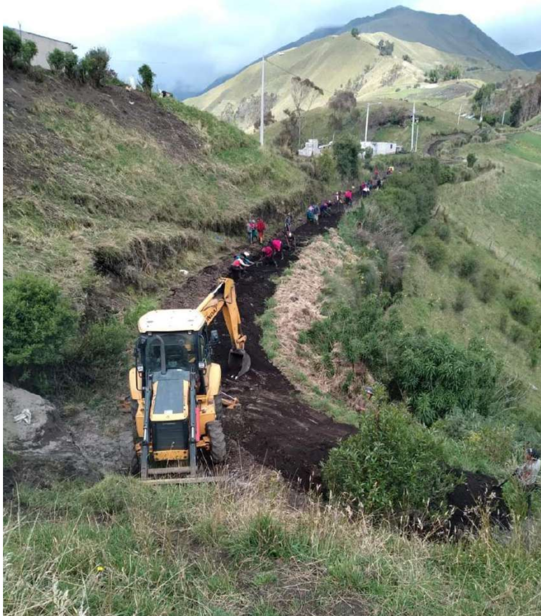
EXCAVACIÓN PARA INSTALAR TUBERÍA EN EL SISTEMA DE AGUA DE CONSUMO HUMANO MOSTE CHICO
