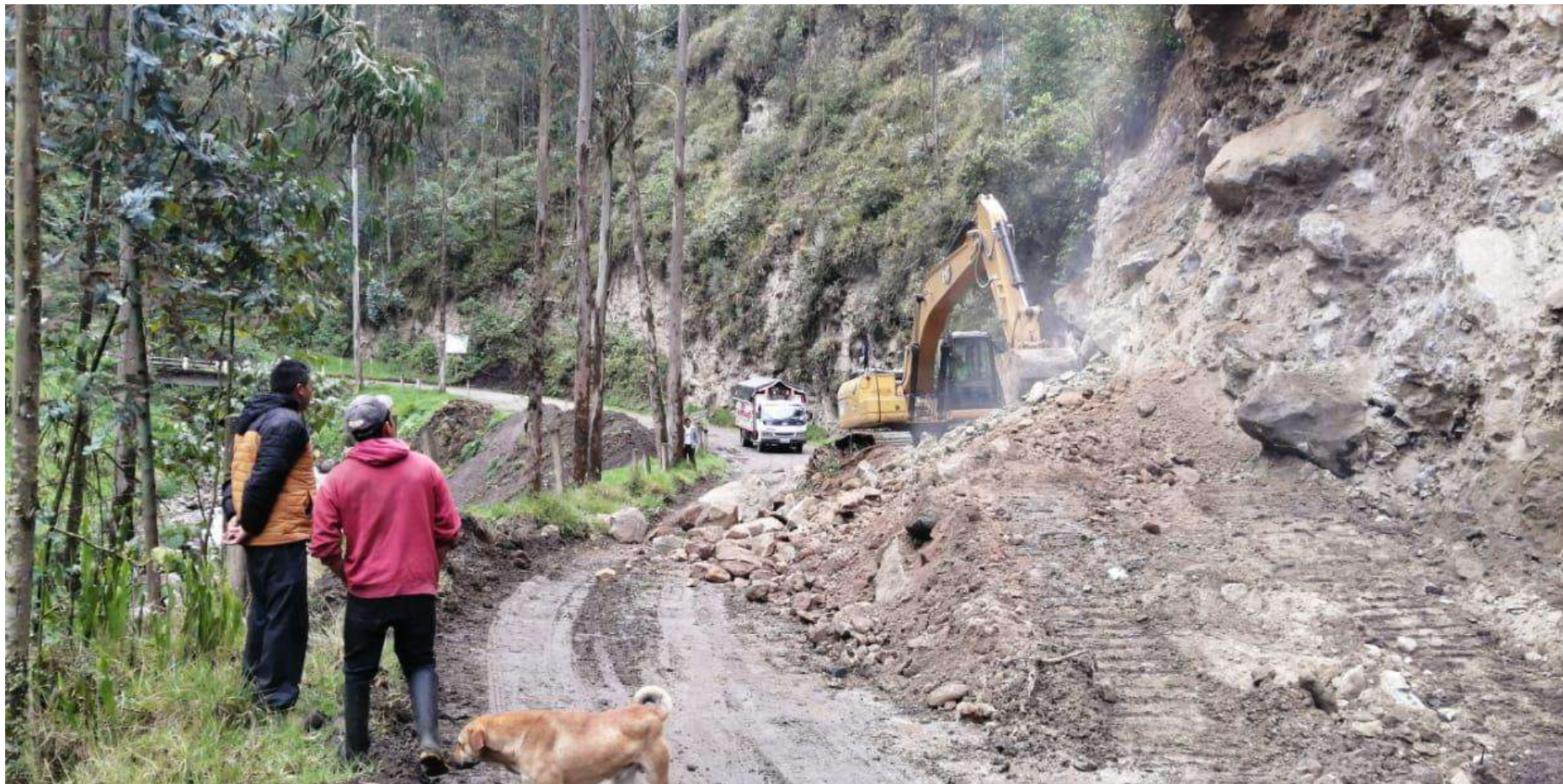
FISCALIZACIÓN A TRABAJOS DE AMPLIACIÓN DE VÍA EN LA COMUNIDAD DALDAL
