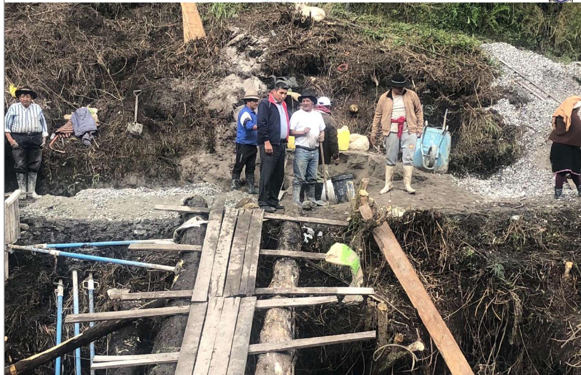
ENTREGA DE CEMENTO PARA PUENTE PEATONAL EN SHULLIDIS
