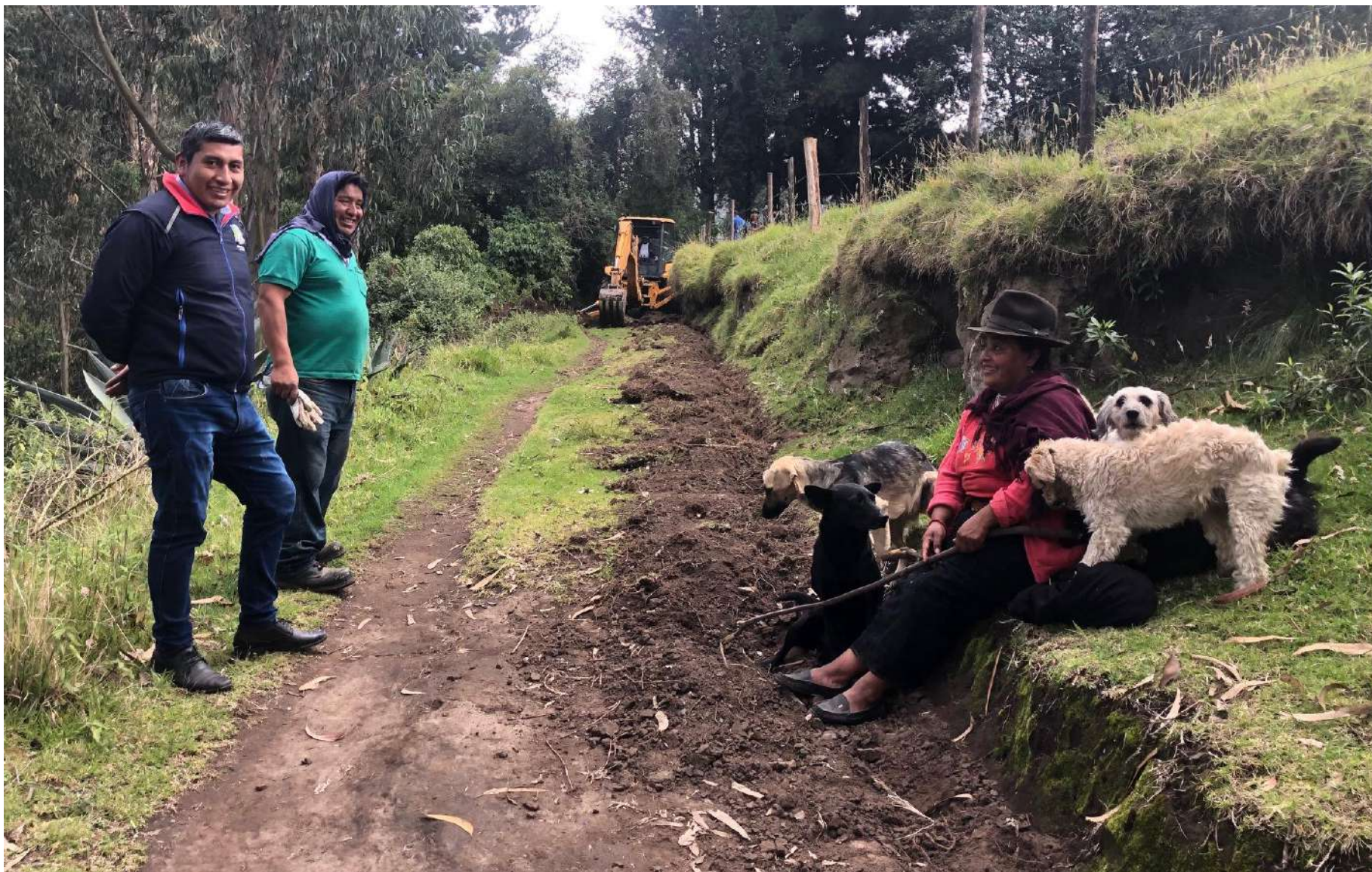
AMPLIACIÓN DE VÍA SECTOR CURTIEMBRE
