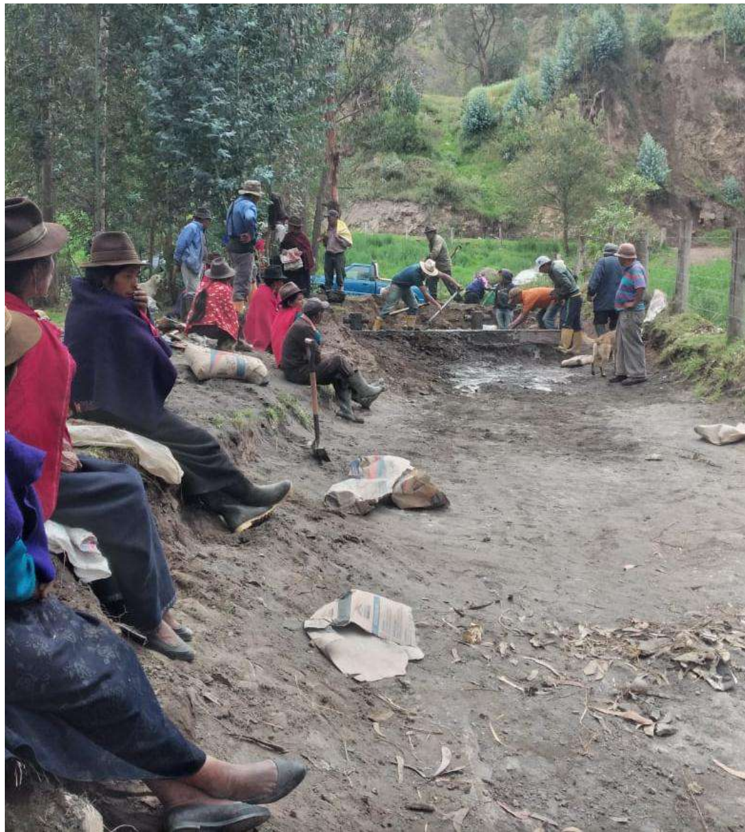
ENTREGA DE CEMENTO PARA PUENTE PEATONAL EN EL SECTOR LAGMO
