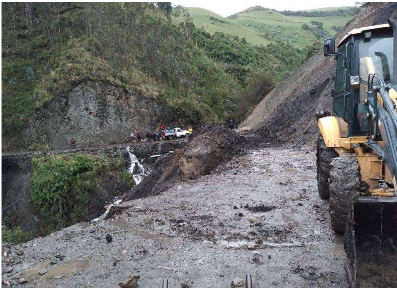
LIMPIEZA PERMANENTE DE LA VÍA PUNGALAPAMBA – PELTETEC – ALAO EN EL SECTOR PUNINHUAYCO CON MAQUINARIA DEL GAD PARROQUIAL
