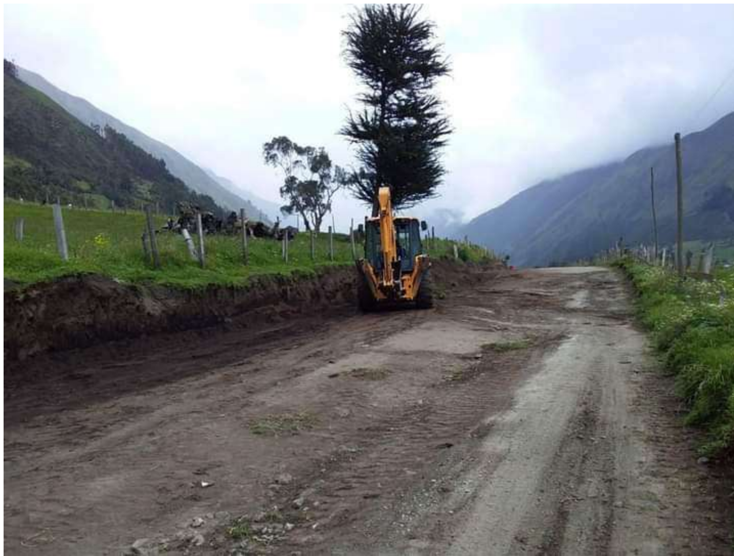
MANTENIMIENTO DEL TRAMO DE LA VÍA A ALAO EN EL SECTOR HACIENDA VIEJA
