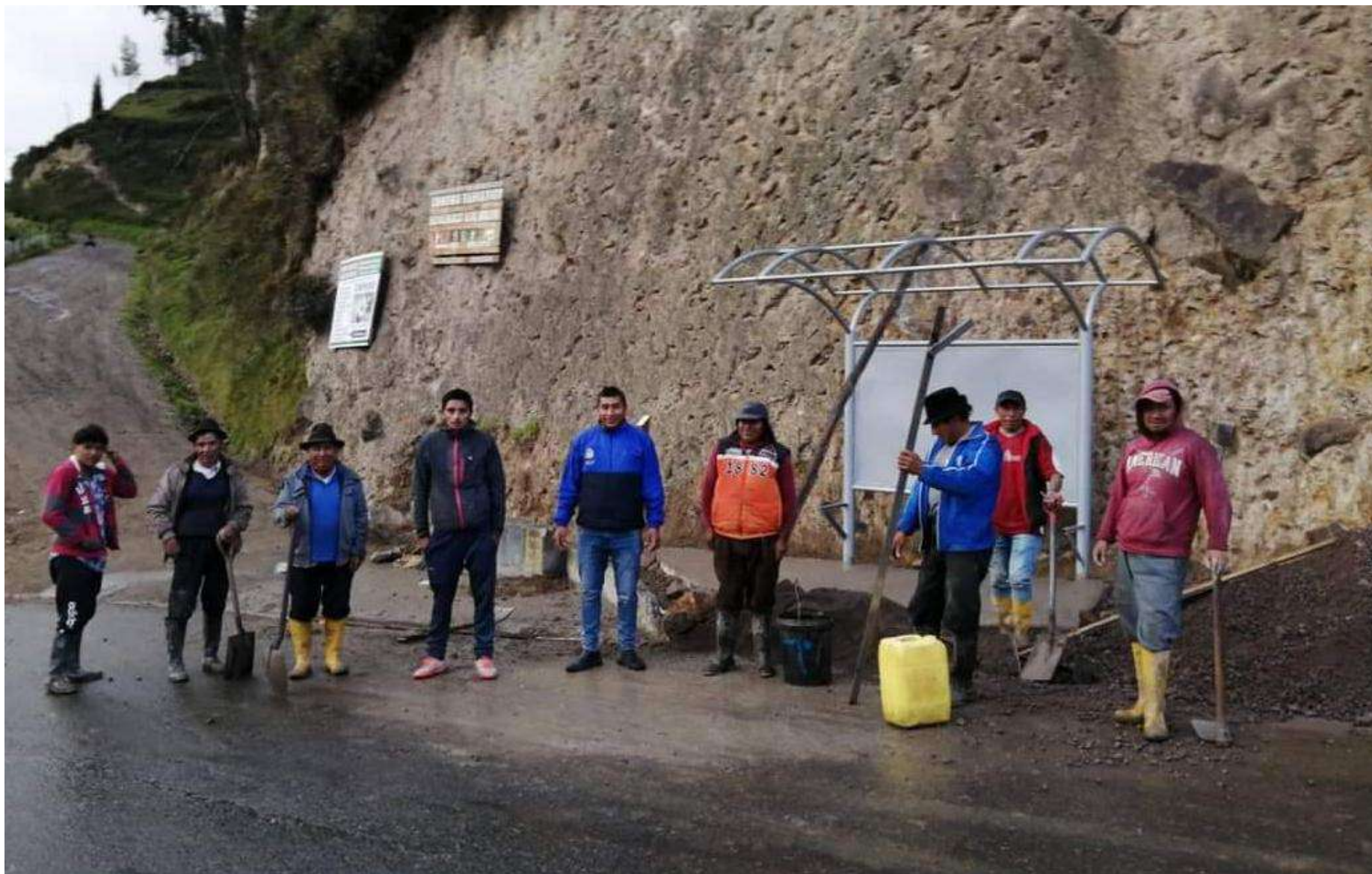
INSTALACIÓN DE PARADAS DE BUS EN LUGARES ESTRATÉGICOS DE LA PARROQUIA INVERSIÓN $ 6000
