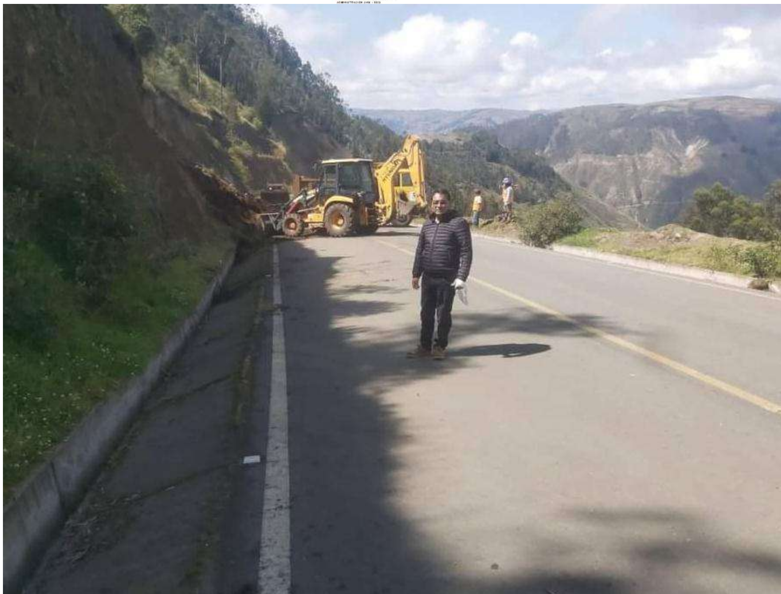
MANTEIMIENTO VIAL EN EL TRAMO PUNGALAPAMBA- PURUHAY LLACTAPAMBA
