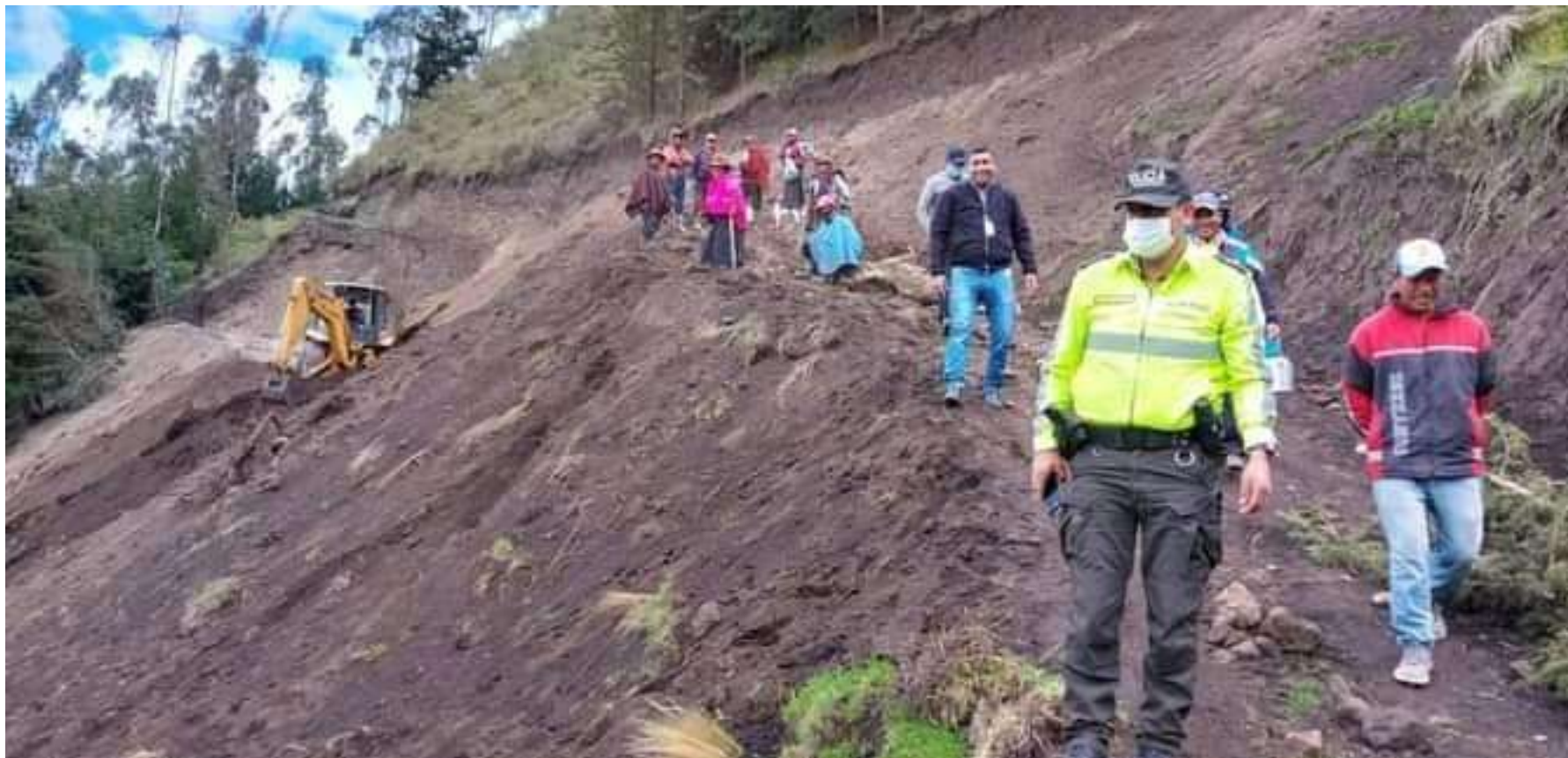
MANTENIMIENTO DE 1,5 KILIMETROS DE VIA EN LA COMUNIDAD CALQUIS, PENDIENTE CONCLUIR
