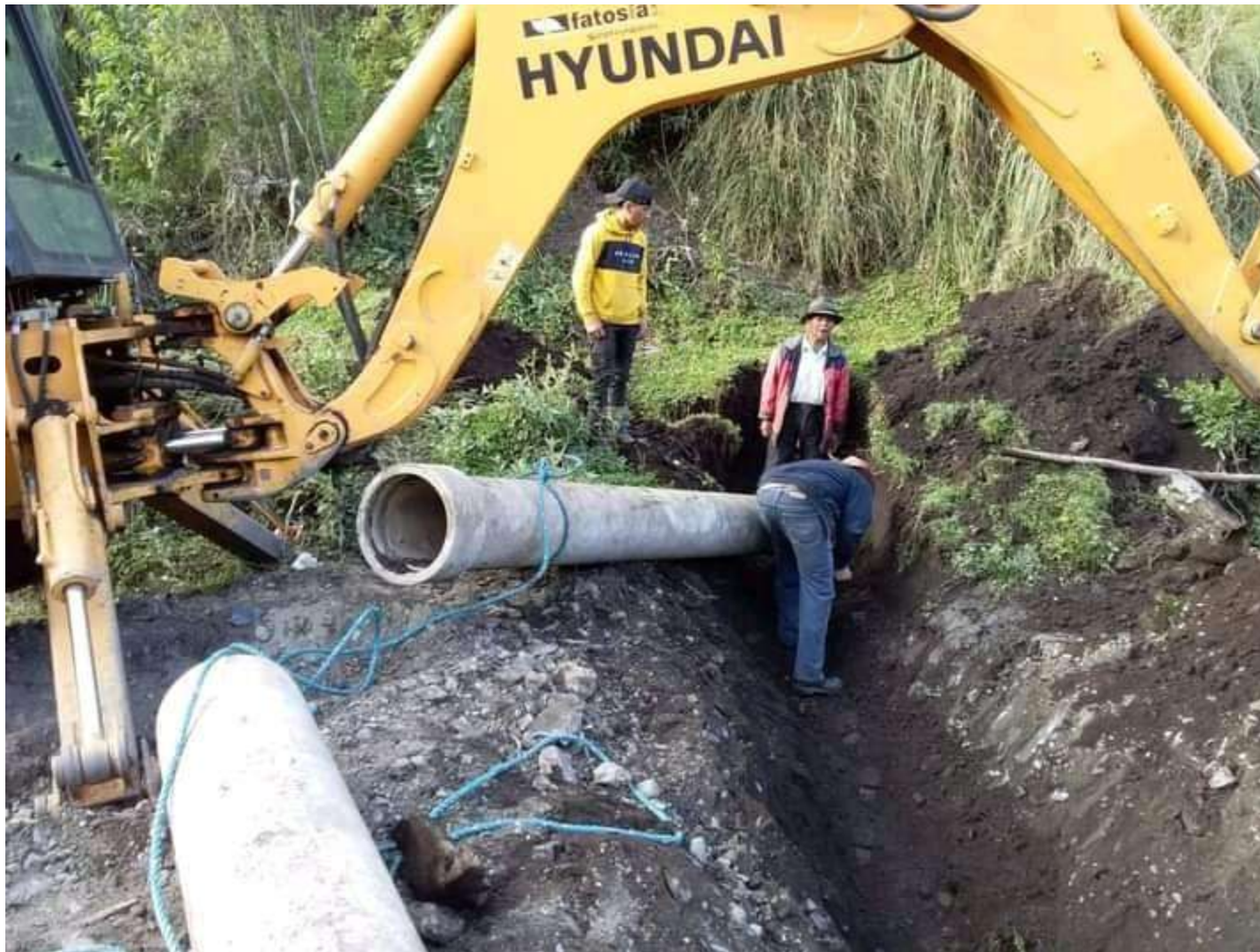
LIMPIEZA DE DERRUMBES Y EXCAVACIÓN PARA PASOS DE AGUA EN EL TRAMO DE VÍA SALPI - MINAS
