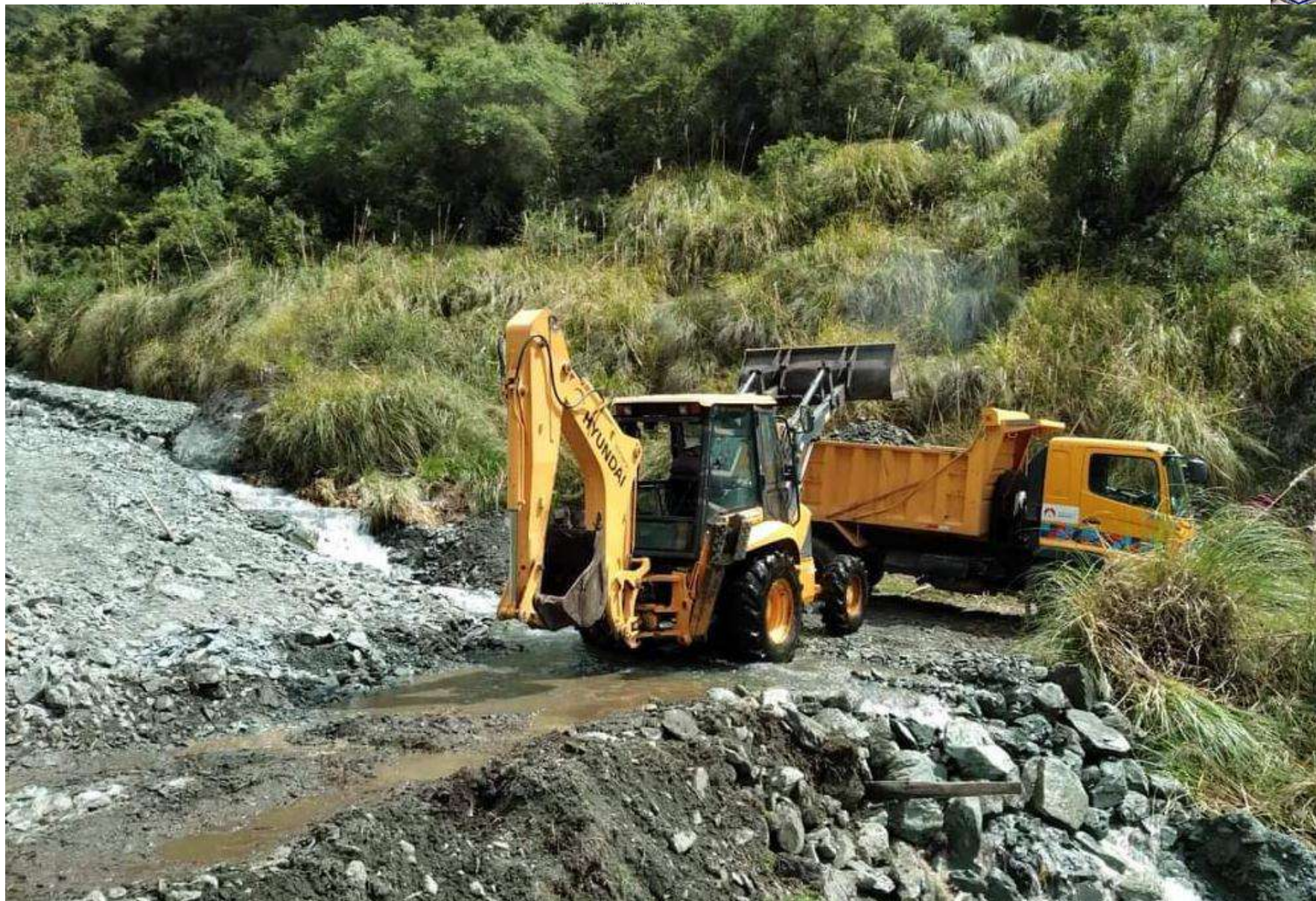
MANTENIMIENTO VIAL EN LA ZONA ALTA DE SAN ANTONIO DE ALAO, EN COORDINACIÓN CON EL MUNICIPIO DE RIOBAMBA
