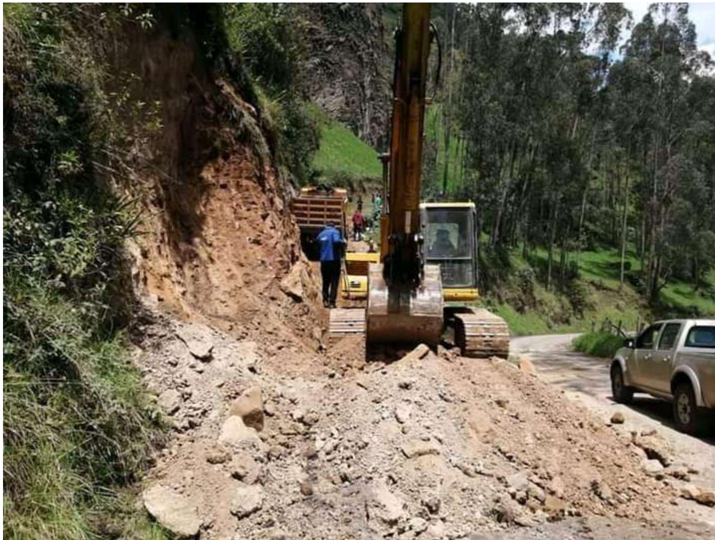
MANTENIMIENTO Y LASTRADO EN LA VÍA DALDAL - GUAMPAC
