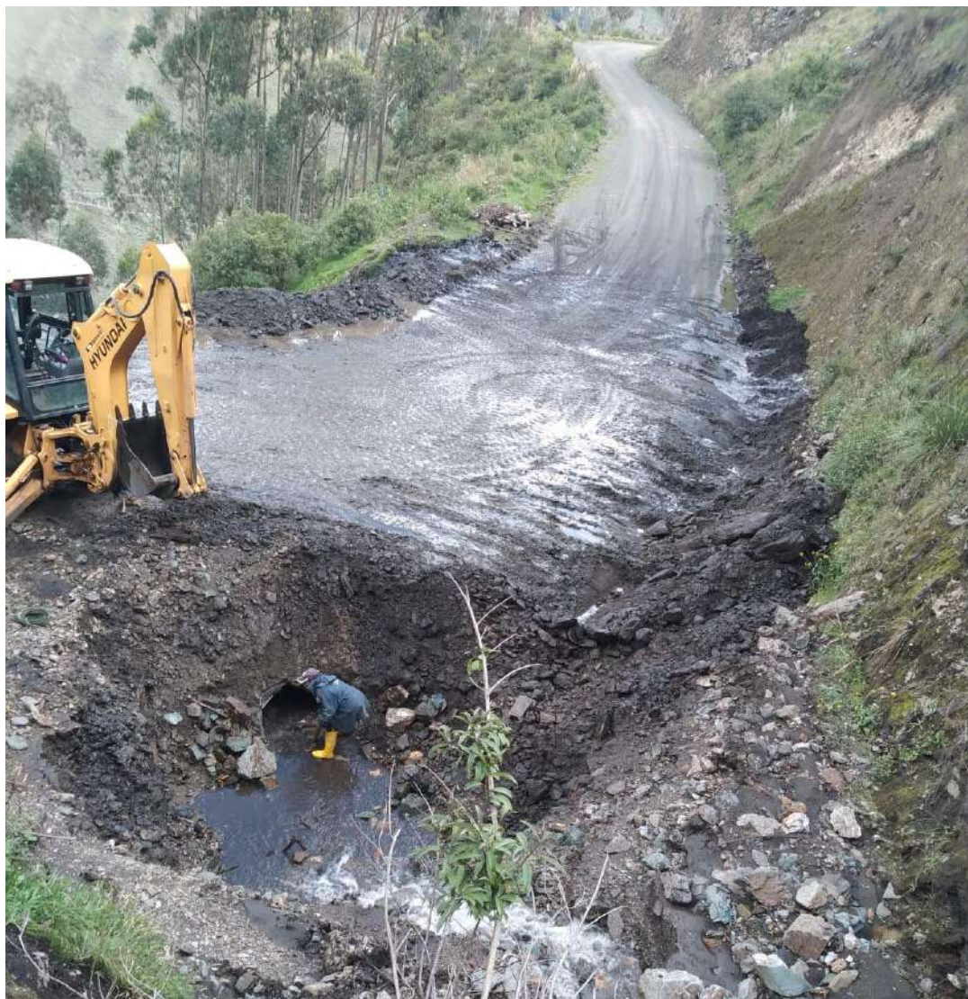
LIMPIEZA DE ALCANTARILLA Y VÍA EN EL SECTOR SALPI
