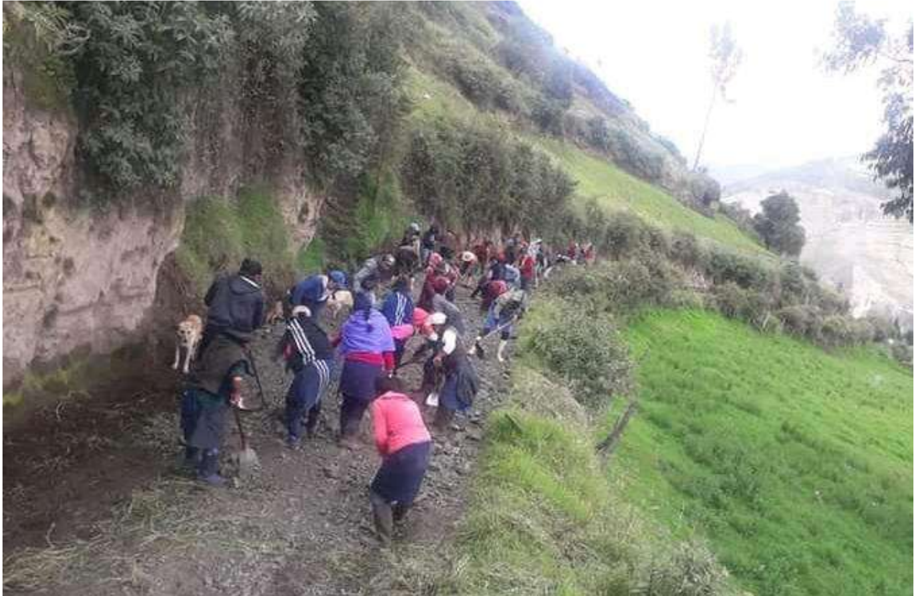
MANTENIMIENTO DEL TRAMO DE VÍA PUNGALAPAMBA –TRESQUILAPAMBA
