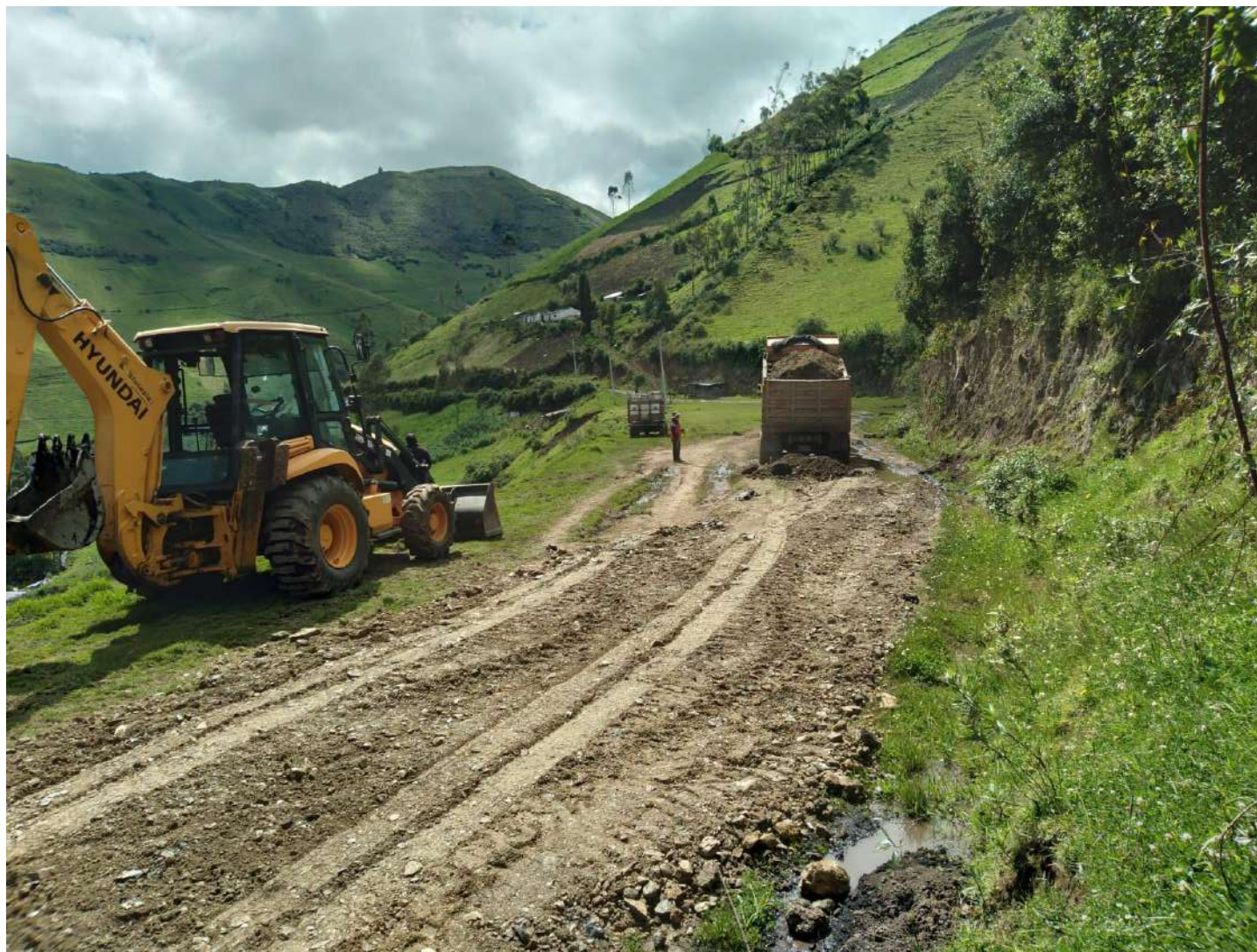
LASTRADO DE VÍA EN CHUSGA
