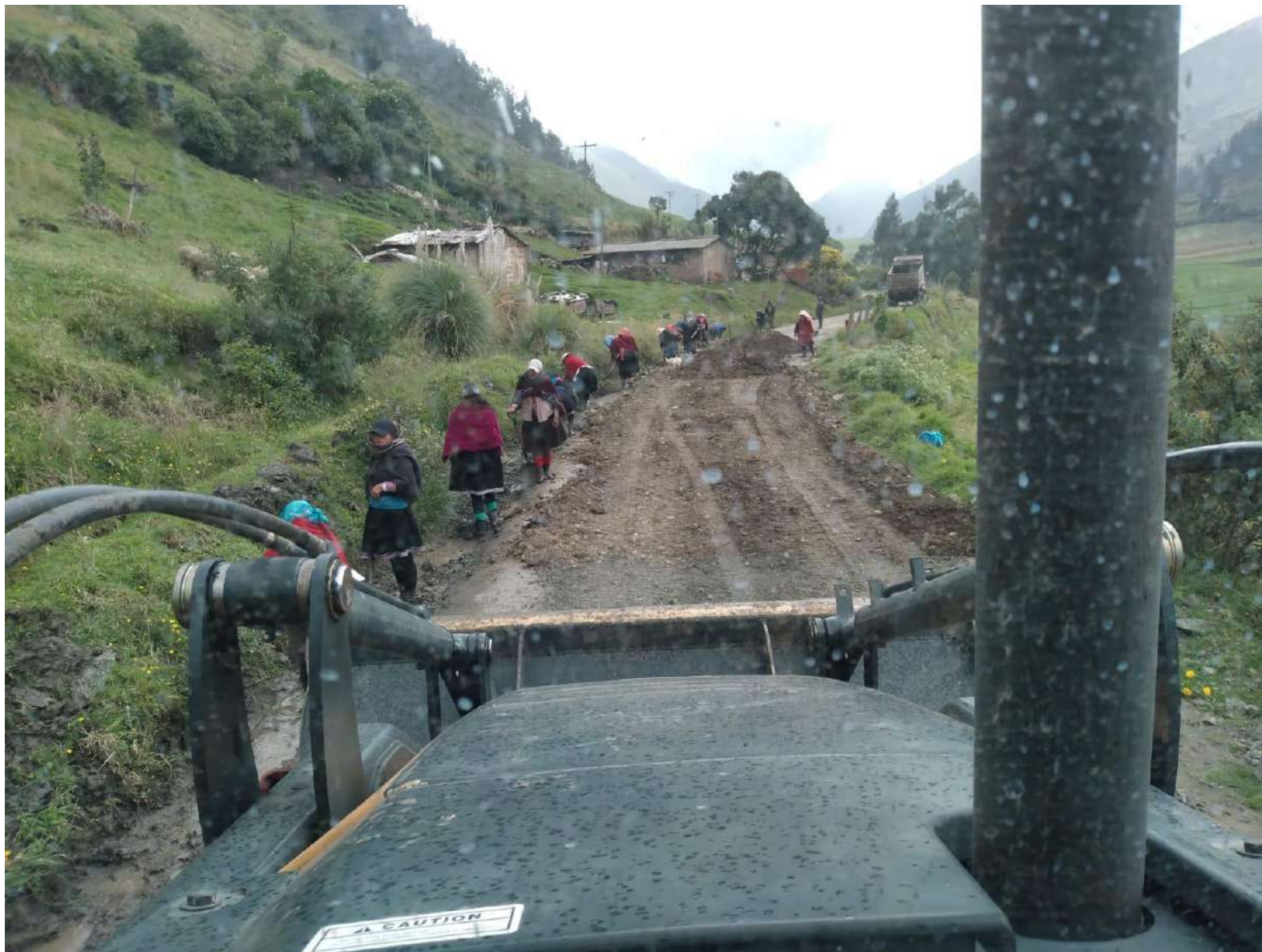
LASTRADO DEL TRAMO DE VÍA PUENTE MAGUAZO - SHULLIDIS
